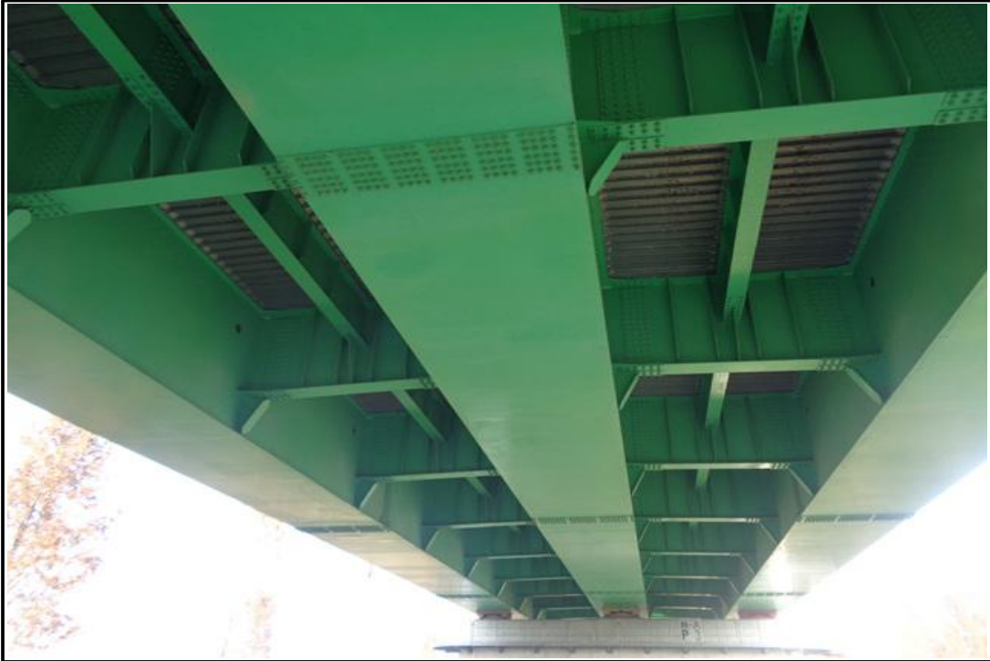
바닥판하면 및 거더 외부 전경
